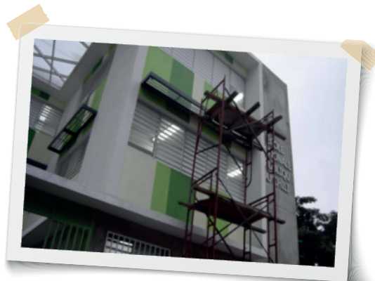
Construcción de la Escuela República de Chile en Haití.
